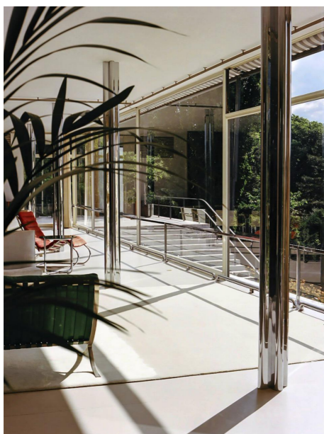
Stützenverkleidung Gemeinschaftsraum verchromtes Stahlblech
